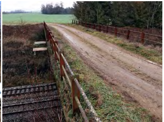
Obr. 6.25 U úzkých nadchodů o šířce do 7 m rozhodují o využitelnosti pro faunu tři faktory: 1. rušení provozem pod nadchodem, 2. povrch (zpevněný vs. nezpevněný), 3. délka. Zatímco úzké a dlouhé mosty přes dálnici nejsou využívány téměř vůbec, podobné, ale kratší mosty přes železnici využívá široké spektrum živočichů. Příkladem mohou být tyto dva obdobné mosty - most přes dálnici D1 (vlevo) není využíván v podstatě žádnými živočichy, most vpravo přes železnici (s nezpevněným povrchem) pravidelně využívá srnec, zajíc či liška, ale také řada bezobratlých. (© Václav Hlaváč)
