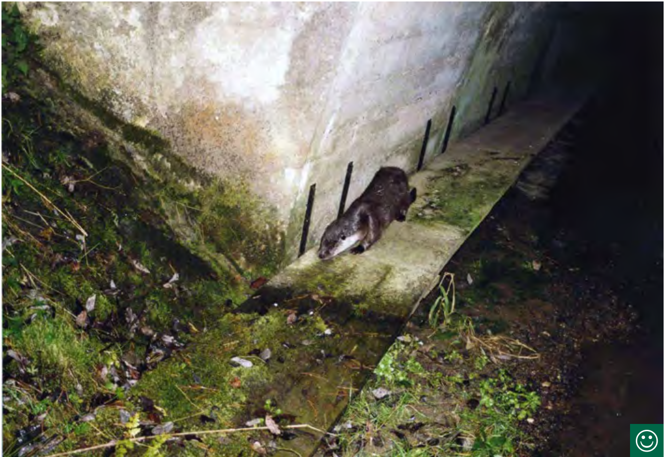
Obr. 10.36 Průchodnost mostů, u kterých voda sahá od opěry k opěře, lze zlepšit instalací 40 cm široké dřevěné lávky, umístěné cca 30 cm nad běžnou hladinou vody. Lávky využívá liška, vydra i všechny menší lasicovité šelmy. Zásadním požadavkem je plynulé napojení lávky na okolní terén. (© Václav Hlaváč)
