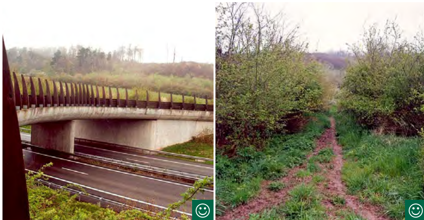
Obr. 10.9 Zelený most s nálevkovitým tvarem může být 40 m široký u vchodu, ale pouze 10 m široký ve svém středu. Taková řešení znamenají finanční úsporu bez významného vlivu na funkčnost. Vyšlapané stezky od kopytníků na snímku vpravo svědčí o intenzivním využívání tohoto nadchodu. Jde o řešení blízké typu N3. Lucembursko. (© Václav Hlaváč)
