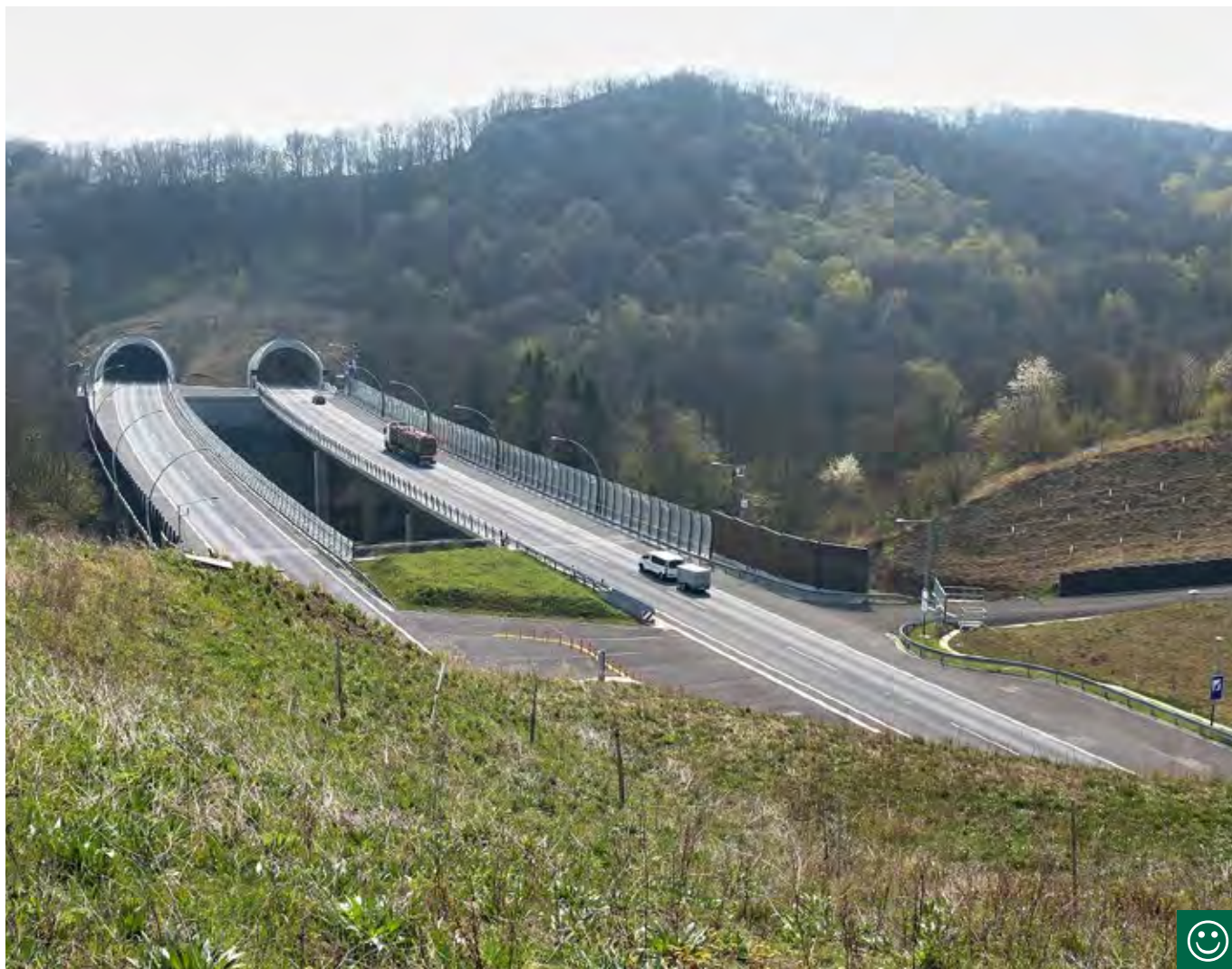
Obr. 10.19 Tunel Prackovice, dálnice D8. (© Tomáš Libosvár)
