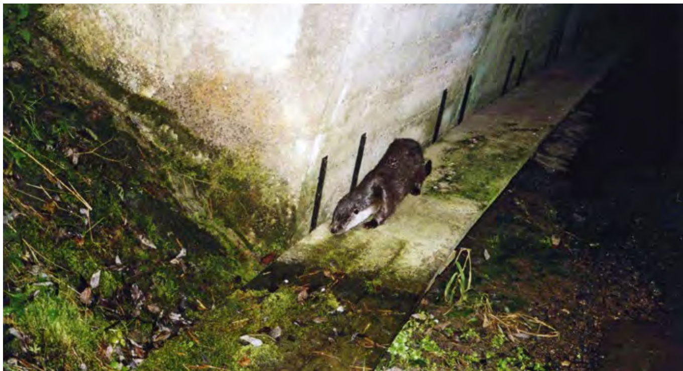
Obr. 6.22 V případě nevhodně řešených mostů, u kterých suché břehy neexistují, je možné dodatečně vybudovat “zvířecí lávky”. I zde musí být zachována přirozená návaznost “chodníku” na břehy toku. (© Václav Hlaváč)
