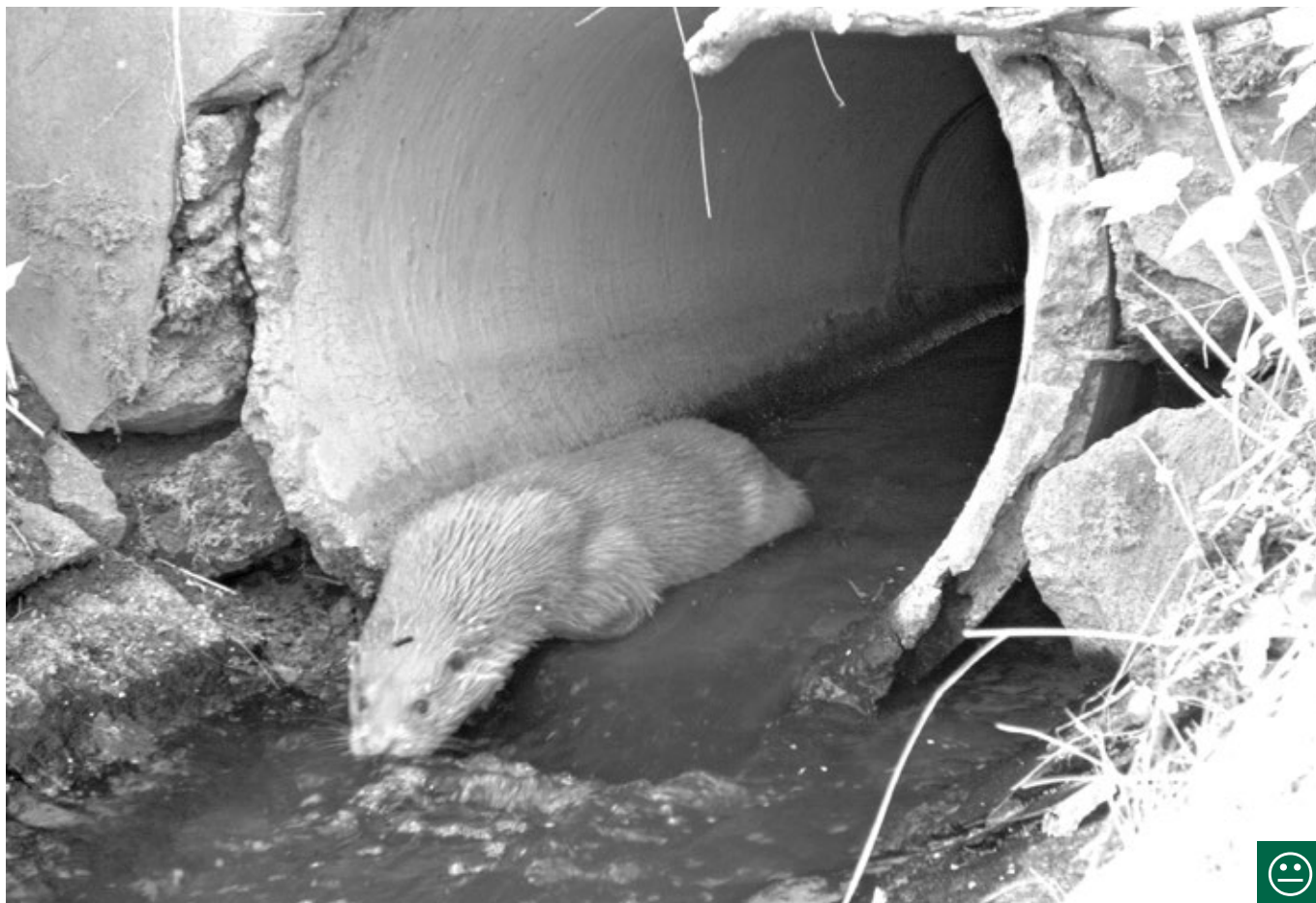
Obr. 10.29 Trubní propustky mohou sloužit jako průchody pro řadu živočichů. Vydry jsou schopné je v době nižšího průtoku vody využívat. Řada dalších druhů preferuje však propustky rámové. (© Václav Hlaváč, fotopast)
