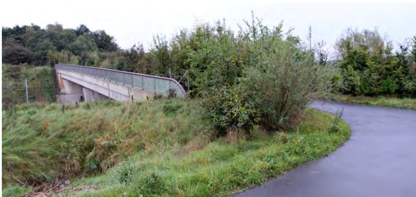
Obr. 6.24 Lesní cesta přes dálnici rozšířená o pruhy s keři po obou stranách umožňuje propojení lesního prostředí pro mnoho druhů živočichů, včetně savců žijících na stromech, drobného ptactva nebo netopýrů. Představuje velmi dostupné opatření s výrazným efektem. Drážďany, Německo. (© Václav Hlaváč)
