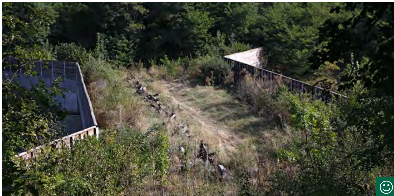
Obr. 10.13 Vegetace na pláni tohoto zeleného mostu byla ponechána samovolnému vývoji, což vede k přirozenému propojení biotopů na obou stranách. Rozšíření okrajů vede ke zkrácení délky nadchodu, což významně zlepšuje jeho využitelnost. Francie. (© Václav Hlaváč)
