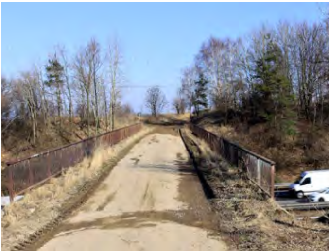
Obr. 6.25 U úzkých nadchodů o šířce do 7 m rozhodují o využitelnosti pro faunu tři faktory: 1. rušení provozem pod nadchodem, 2. povrch (zpevněný vs. nezpevněný), 3. délka. Zatímco úzké a dlouhé mosty přes dálnici nejsou využívány téměř vůbec, podobné, ale kratší mosty přes železnici využívá široké spektrum živočichů. Příkladem mohou být tyto dva obdobné mosty - most přes dálnici D1 (vlevo) není využíván v podstatě žádnými živočichy, most vpravo přes železnici (s nezpevněným povrchem) pravidelně využívá srnec, zajíc či liška, ale také řada bezobratlých. (© Václav Hlaváč)
