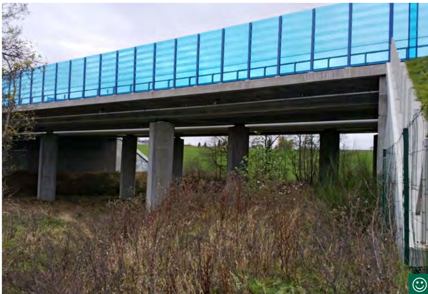
Obr. 10.35 Most přes drobný vodní tok s indexem otevřenosti nad 1,5 umožňuje migraci širokého spektra druhů savců do velikosti srnce či prasete divokého. Využitelnost podchodu výrazně zlepšuje vegetační kryt. Protihluková stěna na mostě zmírňuje rušení dopravou, musí být však vždy upravena tak, aby se minimalizovalo riziko zranění ptáků. (© AOPK ČR)
