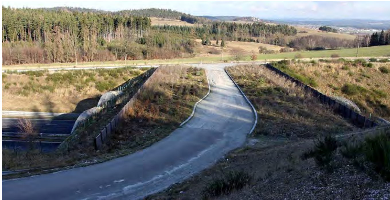
Obr. 6.61 Zelený most kombinovaný s místní asfaltovou komunikací je kompromisním řešením, které nemusí být akceptováno náročnějšími druhy. V místech, ve kterých dálnice kříží migrační koridor velkých savců, je takové řešení neakceptovatelné. (© Václav Hlaváč)
