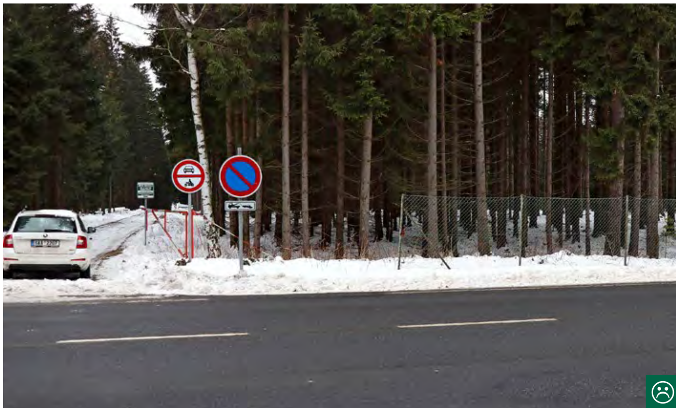
Obr. 10.47 Oplocení přerušené napojením komunikace na lesní cestu. Tato silnice první třídy byla oplocena kvůli vysokému počtu srážek se zvěří. Jelikož je na ni v oploceném úseku napojeno několik lesních cest, ztratilo přerušené oplocení svoji funkčnost. Počet zaznamenaných kolizí se zvěřat v daném úseku po instalaci oplocení dokonce vzrostl. Zvěř překonávající komunikaci se totiž dostala dovnitř oploceného úseku bez možnosti úniku. (© Václav Hlaváč)
