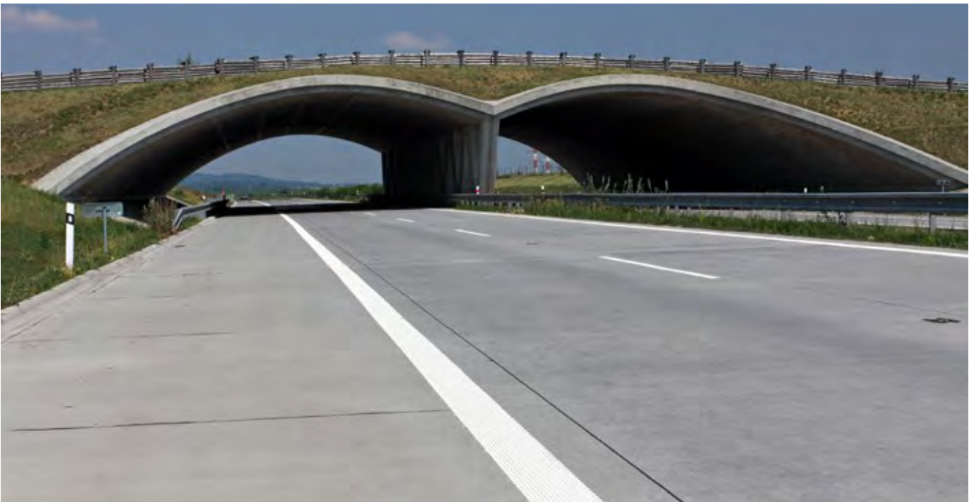
Obr. 9.2 I v rovinaté krajině lze umožnit velkým savcům průchod přes komunikaci pomocí zelených mostů. Navázání takového mostu na okolní krajinu však vyžaduje zábor větší plochy. (© Václav Hlaváč)
