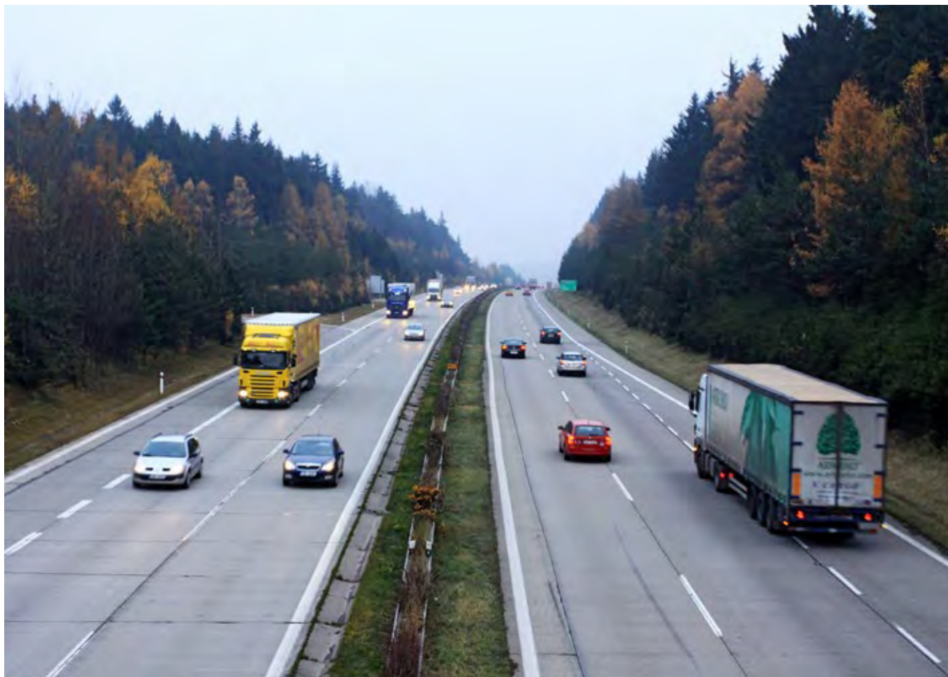
Obr. 9.5 Trasa dálnice D1 přes Českomoravskou vrchovinu byla navržena tak, že nepřekonává žádné větší vodní toky a průchod členitým terénem je často řešený prostřednictvím masivních zářezů a násypů. V úseku mezi Koberovicemi a Velkým Meziříčím (80 km) není proto žádný most, který by byl využitelný jako průchod pro středně velké a velké savce. (© Václav Hlaváč)
