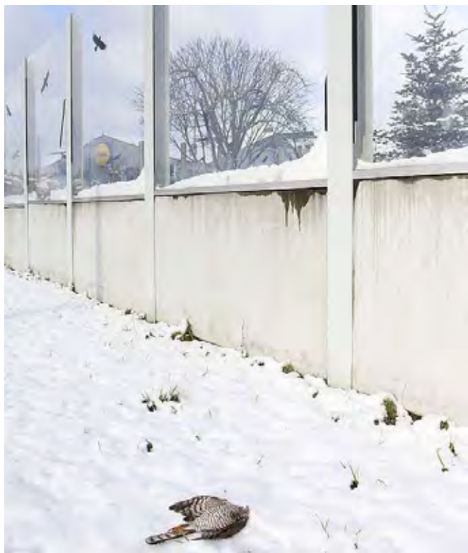
Obr. 6.10 Prosklené stěny jsou častou příčinou úrazů ptáků mnoha skupin. Z dravců bývá nejčastější obětí krahujec obecný. Dříve používané siluety ptáků nemají žádnou účinnost, ptáci často narážejí do skla těsně vedle siluet. Viditelné prvky, nejlépe svislé pruhy, by měly mít pokryvnost minimálně 15 % z celkové plochy. (© Václav Hlaváč)
