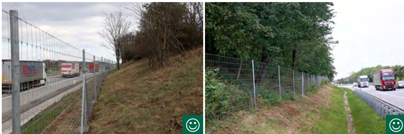
Obr. 10.50 Vhodné umístění oplocení. Stromy a keře představují atraktivní biotop pro široké spektrum druhů a měly by tedy zůstat mimo oplocenou oblast. Kontrola funkčnosti takto umístěného oplocení je zároveň jednodušší než u oplocení umístěného až na hraně zářezu či náspu. (© Václav Hlaváč)
