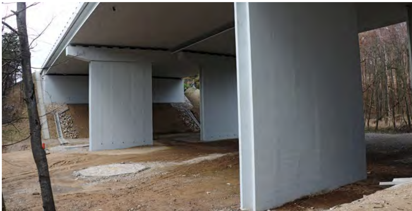
Obr. 9.7 Optimálním řešením pro překonání drobných údolí je dostatečně velký most. Pokud je prostor pod mostem ponechán bez technického zpevnění, není nutné realizovat žádné vegetační úpravy, ozelenění zde proběhne velmi rychle a samovolně podle světelných a srážkových podmínek pod mostem (nově rekonstruovaný most na dálnici D1). (© Václav Hlaváč)
