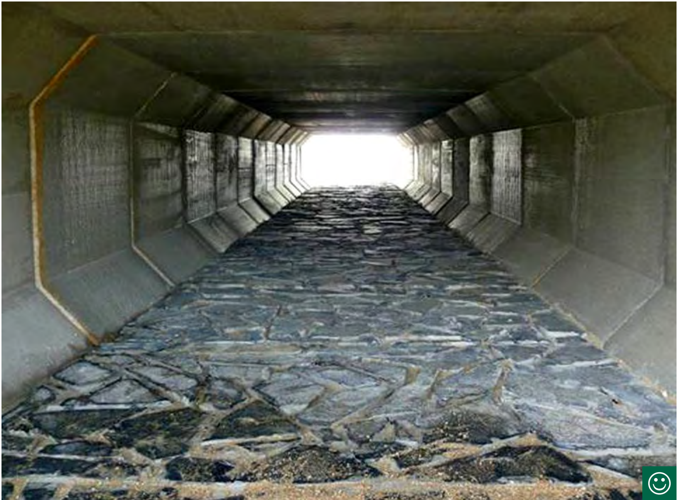
Obr. 10.66 V porovnání s trubním propustkem je pro migraci obojživelníků rámový propustek vždy lepším řešením. Povrch podchodu je pro tyto živočichy velmi důležitý, přičemž kamenná dlažba je vhodnou volbou. (© Václav Hlaváč)
