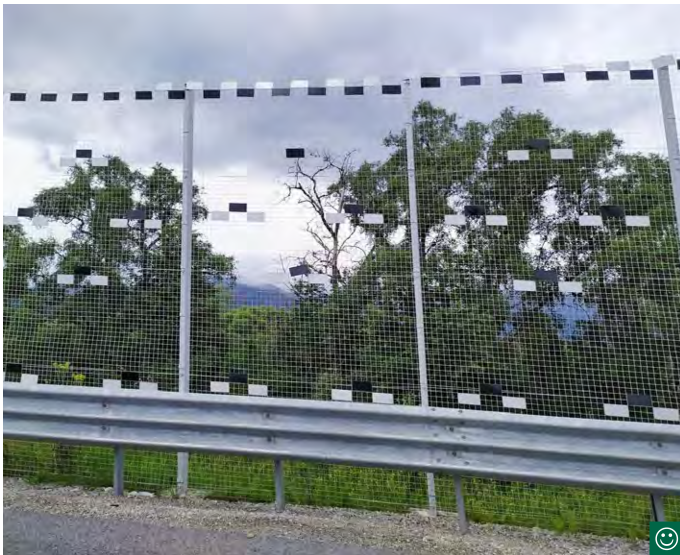
Obr. 10.58 Pletivové stěny o výšce 4,5 m představují účinnou ochranu především vodních ptáků před srážkami s vozidly. Účinnost pro letouny není dosud ověřená (Slovensko, dálnice D1 v údolí Váhu). (© Václav Hlaváč)
