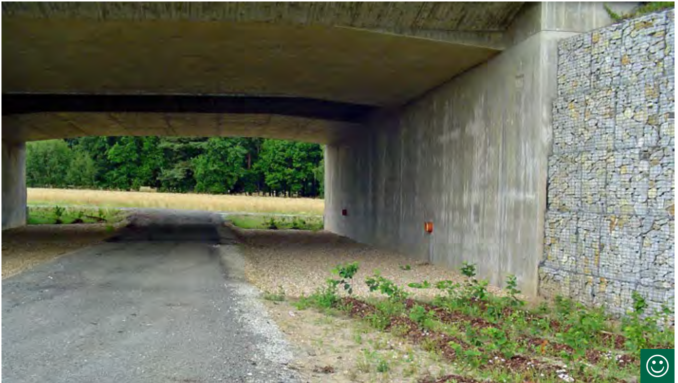
Obr. 10.38 Optimalizovaný podchod přes účelovou komunikaci představuje obvykle plně funkční podchod pro živočichy do velikosti srnce a prasete divokého, za optimálních podmínek může být využit i velkými šelmami, jelenem nebo losem. (© Jana Kloubcová)
