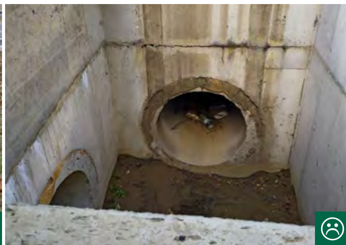
Obr. 10.30 Sedimentační jímky na vpusti nebo výtoku zamezují migracím obojživelníků. Takováto technická řešení navíc mohou představovat pasti bez možnosti úniku, ve kterých umírají desítky obojživelníků. (© Václav Hlaváč)
