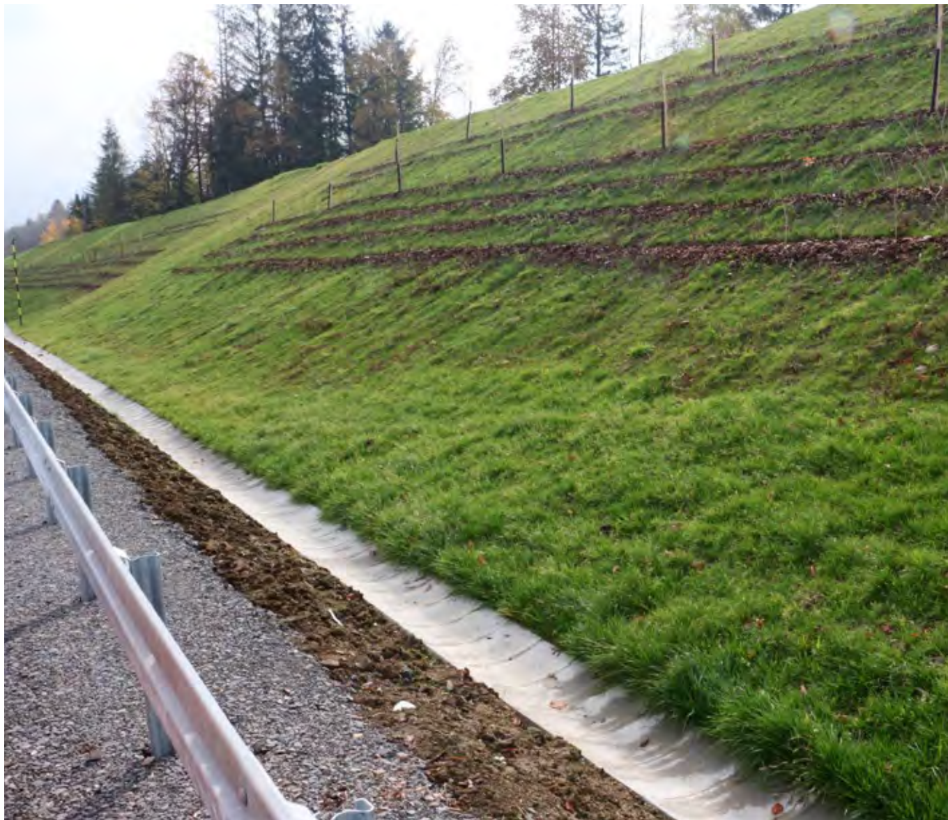
Obr. 9.15 Výsadba vegetace se často provádí za účelem stabilizace svahu. Keřový a stromový pokryv však může vytvářet atraktivní stanoviště pro středně velké a velké druhy savců a lákat je do blízkosti provozu. (© Otakar Kozák)
