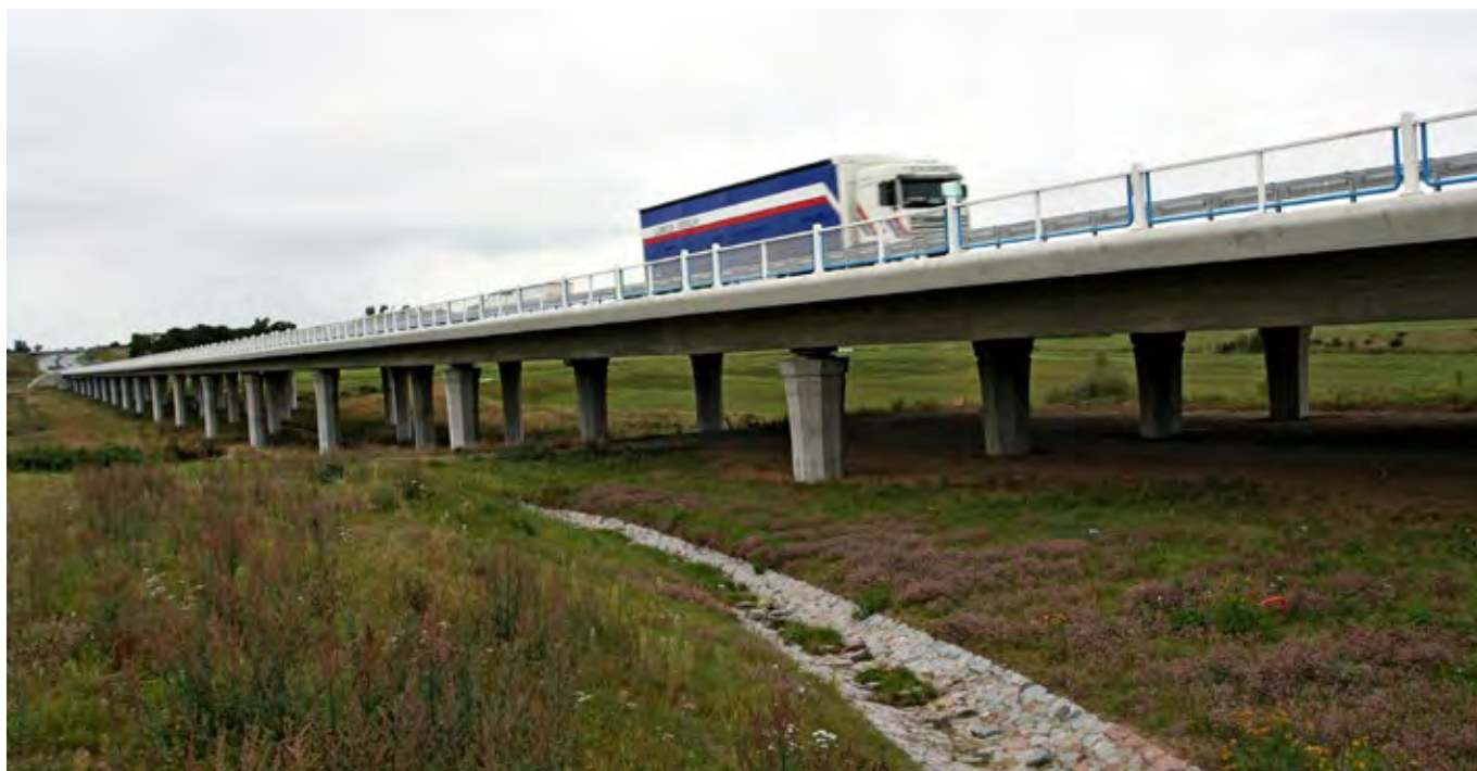
Obr. 9.4 V záplavových územích je optimálním řešením estakádový most, který umožní rozliv vody při povodních a zároveň umožňuje dobrou průchodnost pro většinu živočichů. (© Václav Hlaváč)
