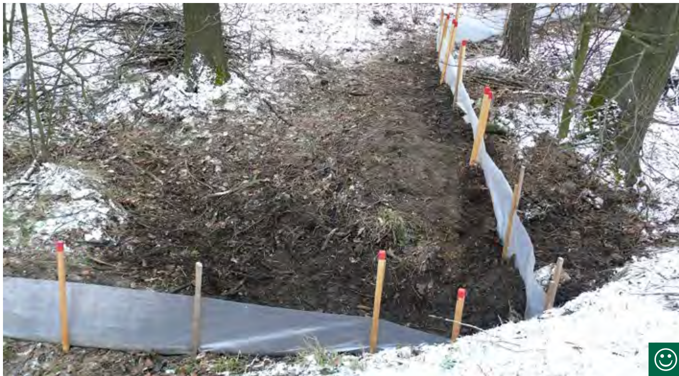
Obr. 10.70 Instalace dočasných zábran během jarní migrace může zabránit vstupu obojživelníků na komunikaci a zároveň je nasměrovat k bezpečnému podchodu. Po období migrace musí být zábrany odstraněny. Jarošovský Kacíř, Třebíč (© Jaromír Maštera)
