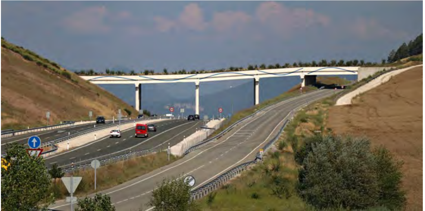
Obr. 10.18 V praxi se často objevují situace, kdy je nutné překonat jedním nadchodem více souběžných bariér (dálnici a souběžnou silnici, dálnici a železnici, dálnici, silnici a vodní tok apod.). Jde obvykle o velmi specifická, technicky a ekonomicky náročná opatření, která nelze metodicky sjednotit. Řešení musí být vždy založené na podrobném expním posouzení konkrétní situace. (© Václav Hlaváč)
