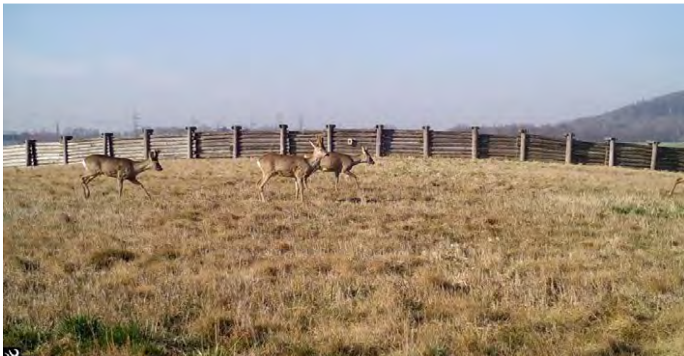
Obr. 6.29 Zelené mosty představují ideální řešení pro většinu kategorií živočichů. Středně velcí savci, jako je např. srnec obecný, využívají tyto nadchody dokonce i v případech, kdy nejsou osázeny keří. Využitelnost velkými savci (např. jelen evropský) nebo velkými šelmami je však v takovém případě omezená. Česká republika, dálnice D1, Suchdol nad Odrou. (© Hnutí DUHA Olomouc, fotopast)
