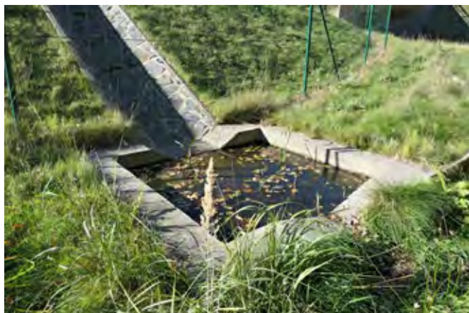
Obr. 9.13 Nevhodně řešené retenční nádrže se při poklesu hladiny stávají pastí pro řadu malých živočichů. U takovýchto nádrží je nutné alespoň jednu stěnu řešit ve sklonu 1:1 tak, aby živočichové mohli za jakéhokoliv stavu vody nádrž opustit. © Petr Anděl (vlevo), © Václav Hlaváč (vpravo)
