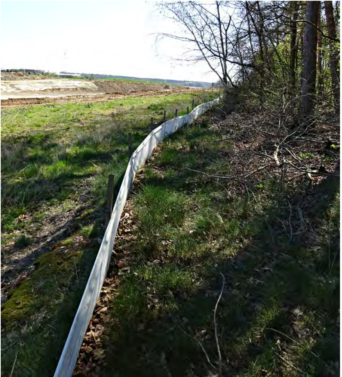
Obr. 8.4 Dočasné bariéry slouží k zamezení vstupu obojživelníků na staveniště. Živočichové by v takových případech měli být naváděni k vhodným průchodům nebo odchyceni a přemístěni do vhodného prostředí. (© Jitka Uhlíková)
