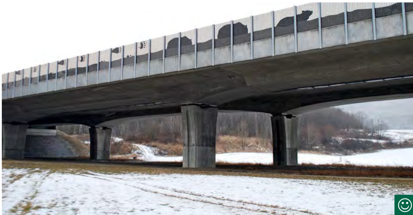
Obr. 10.40 Speciální podchody pro velké savce jsou budovány v místech, ve kterých dálnice kříží migrační koridor. Dálnice D1, Běloutín, Česká republika. (© Martin Strnad)
