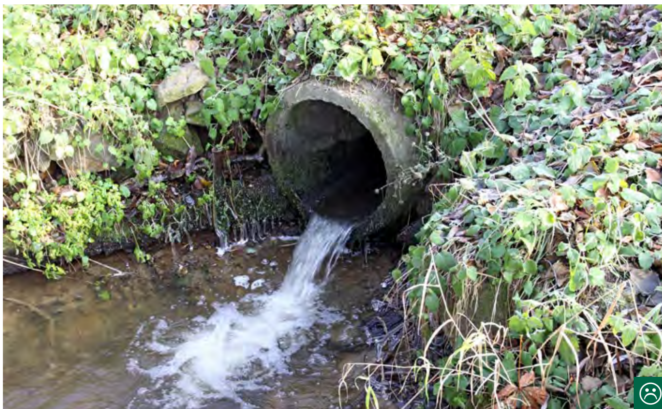
Obr. 10.24 Výškový stupeň mezi vodní hladinou a vyústěním propustku představuje migrační bariéru pro ryby, jako je např. střevle potoční nebo pstruh potoční. (© Václav Hlaváč)
