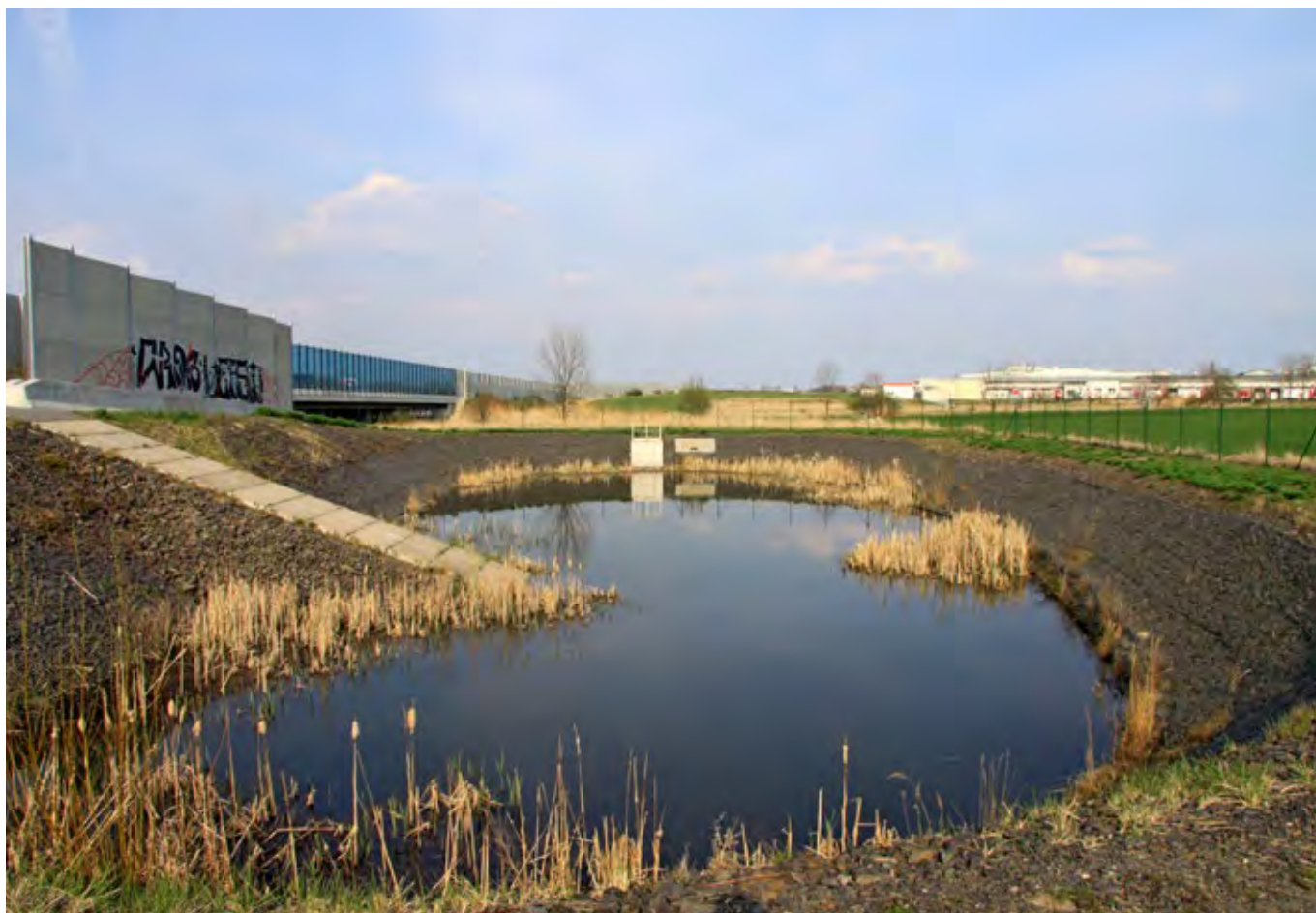
Obr. 9.14 Retenční nádrž bez betonových břehů umožňuje alespoň částečný rozvoj vegetace a osídlení živočichy. V případě havárie je však nutné respektovat její primární účel, kterým je zachycení znečišťujících látek. (© Martin Strnad)
