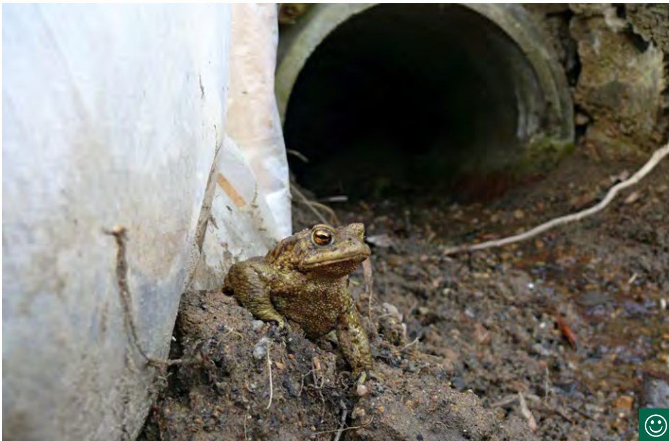
Obr. 10.65 Nejčastějším cílovým druhem při řešení migrace obojživelníků přes komunikace je ropucha obecná. Trubní propustky jsou pro tento druh přijatelné pouze v případě, je-li uvnitř dostatek světla a dno je pokryto nánosy splavenin. (© Jaromír Maštera)
