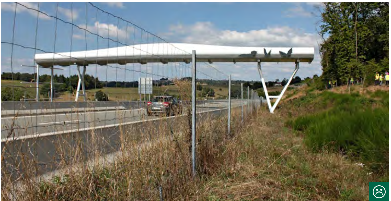
Obr. 10.77 Nadletové navaděče (tzv. gaintries) jsou opatřením, které má navádět letouny k bezpečnému přeletu nad komunikací. Bohužel poslední výzkumy ukazují na jejich malou efektivitu. Francie. (© Morten Elmeros)
