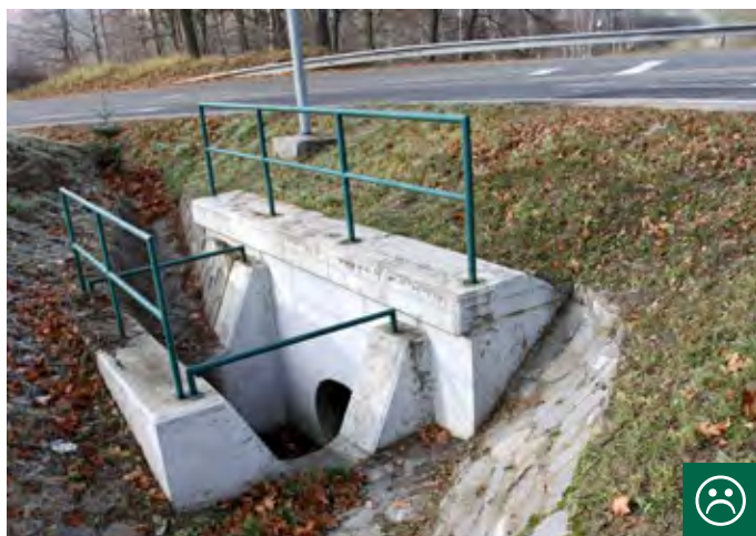
Obr. 10.30 Sedimentační jímky na vpusti nebo výtoku zamezují migracím obojživelníků. Takováto technická řešení navíc mohou představovat pasti bez možnosti úniku, ve kterých umírají desítky obojživelníků. (© Václav Hlaváč)
