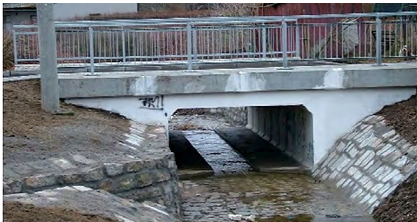
Obr. 6.49 Suché břehy pod mostem musí být vždy plynule napojeny na okolní terén – břehy před a za mostem. Pokud tato podmínka není splněna jako v tomto případě, je most pro suchozemské živočichy nevyužitelný. (© Václav Hlaváč)
