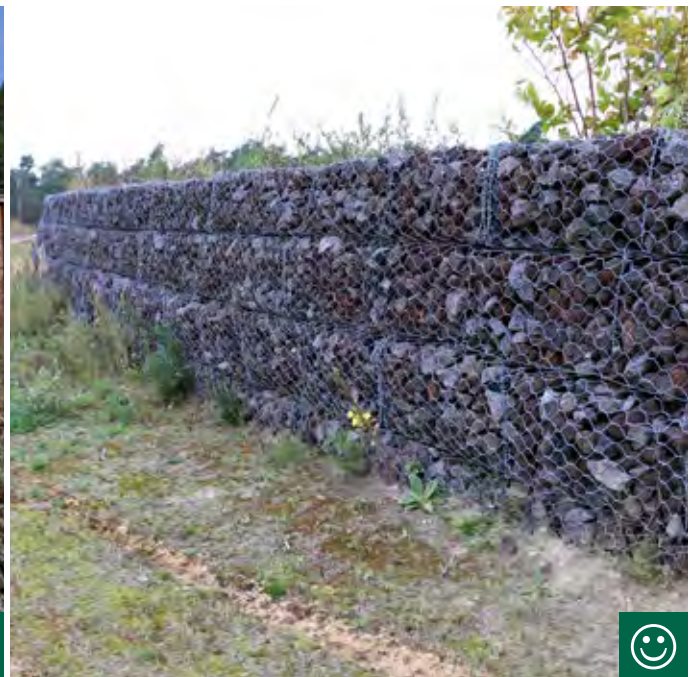
Obr. 10.15 Protihlukové stěny efektivně omezují rušivé vlivy okolního provozu. Mohou být vybudovány ze dřeva (foto vlevo), plastu, nebo jako kamenné stěny (foto vpravo). Kamenné stěny jsou nákladnější a představují vyšší statickou zátěž mostu, avšak vytvářejí nové bioty (např. pro plazy) a jejich životnost je prakticky neomezená. (© Václav Hlaváč)
