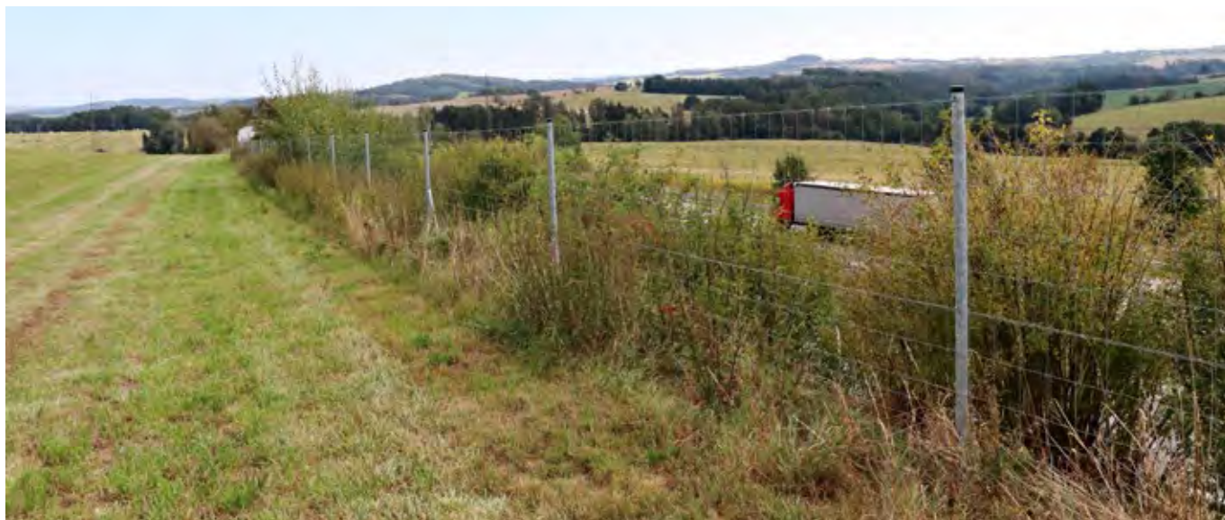
Obr. 9.20 Vzrostlá vegetace mezi dálnicí a oplocením přitahuje živočichy, protože se často jedná o jedinou vegetaci v intenzivně využívané zemědělské krajině. Je-li plot poškozen, zvířata se mohou snadno dostat mezi plot a dálnici. Současně takto umístěný plot není možné kontrolovat z dálnice, takže případné poškození nemůže být včas odhaleno. (© Václav Hlaváč)
