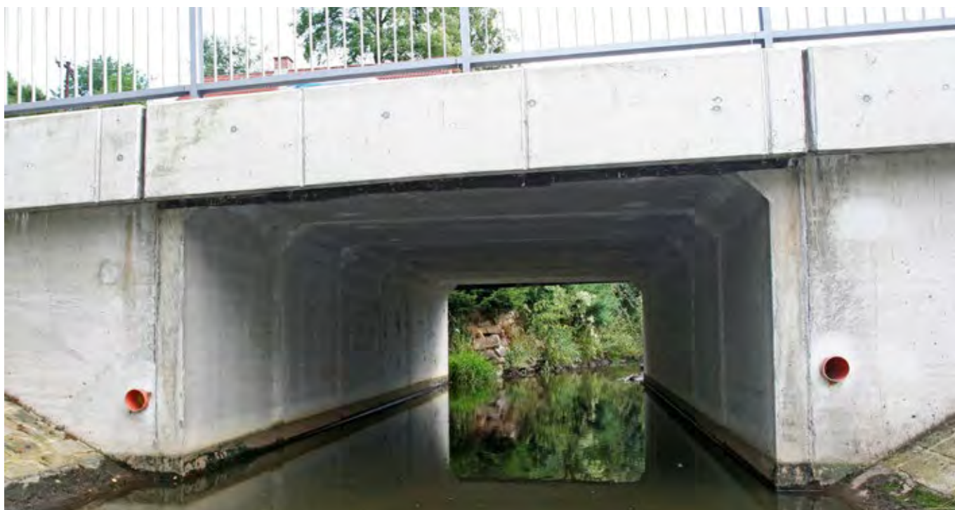
Obr. 4.3 Most bez suchých břehů vytváří “psychickou bariéru“ pro vydry. Přestože jsou zvířata fyzicky schopná takový most podplavat, zkušenosti ukazují, že většina vyder tyto podchody nevyužívá a místo toho přechází vrchem přes silnici. (© Václav Hlaváč)
