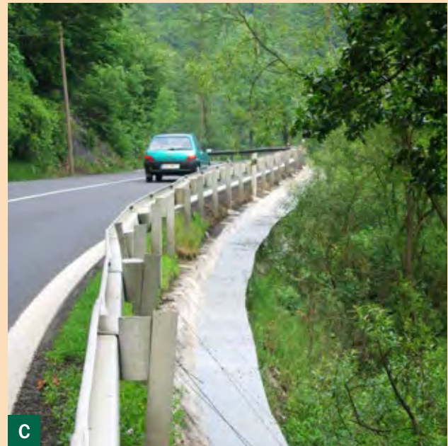
Obr. 6.8 případová studie: Speciální bariéra k zamezení mortality užovky stromové v Poohří. (© Radka Musilová)
