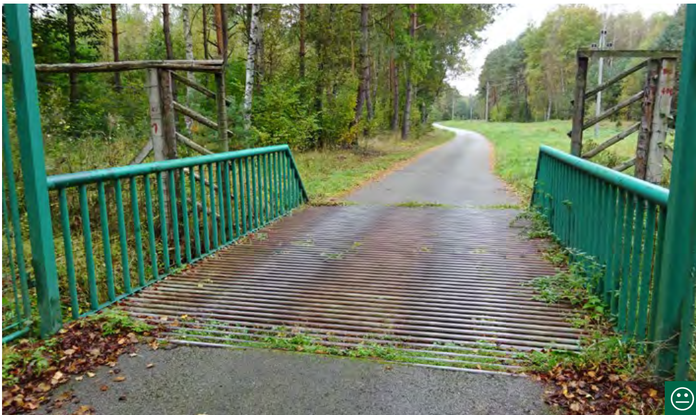
Obr. 10.53 Texaská brána se v ČR používá např. u vjezdů do některých obor. Za běžných podmínek spolehlivě brání úniku kopytníků ze zaplaceného prostoru, ve specifických situacích však nelze vyloučit úrazy zvířat. Obora Židlov. (© Jitka Uhlíková)
