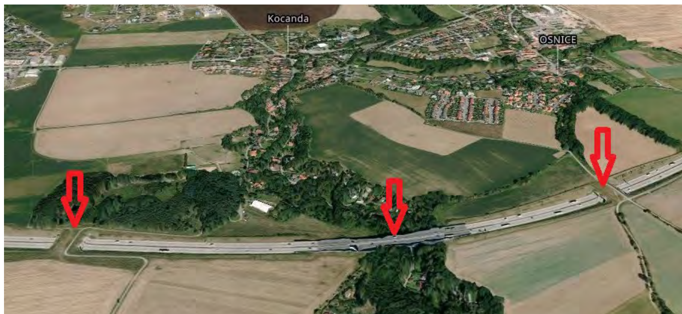
Obr. 6.60 Hustota průchodů pro faunu je klíčovým problémem při řešení průchodnosti dopravní infrastruktury pro faunu. Přístupy k této otázce se v minulých desetiletích vyvíjely - zatímco např. dálnice D1 (zprovozněná 1980) je v 80 km dlouhém úseku přes Českomoravskou vrchovinu pro velké savce zcela neprůchodná, byly na tomto 1 km dlouhém úseku pražského okruhu vybudovány tři velké průchody pro faunu. (© Seznam.cz a.s.)
