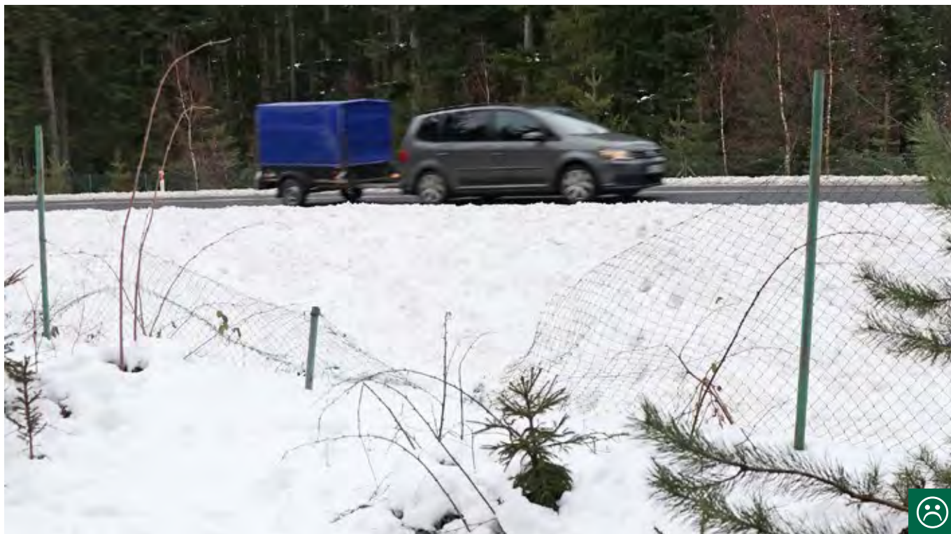
Obr. 10.48 Oplocení je často poškozené např. padlými stromy nebo po nehodách. Zvěř obvykle takoveto otvory najde velmi rychle a dostává se tak do nebezpečné oblasti uvnitř oplocení. V případě vyrušení pak vyběhne přímo na komunikaci a stává se obětí dopravy. (© Václav Hlaváč)
