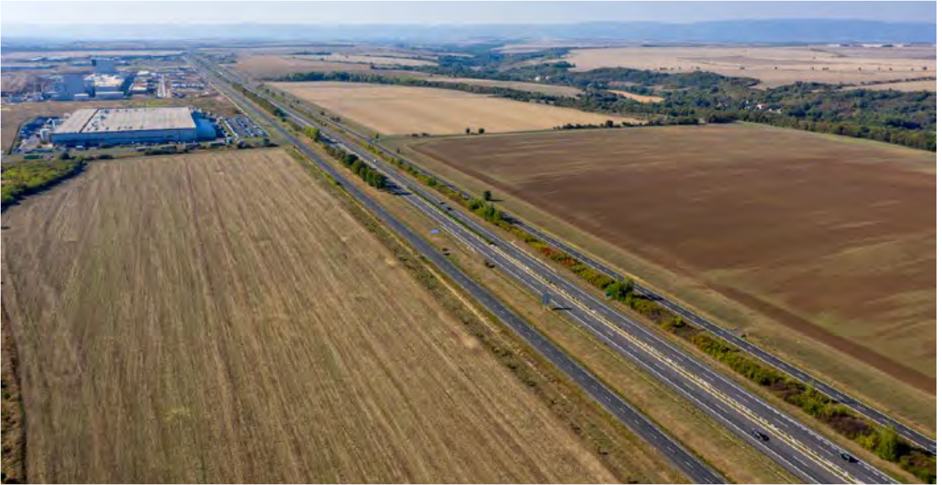
Obr. 9.1 Umístění silnice do úrovně terénu není v rovinaté krajině vizuálně příliš rušivé, poskytuje však pouze omezené možnosti začlenění účinných průchodů pro faunu. (© ŘSD)
