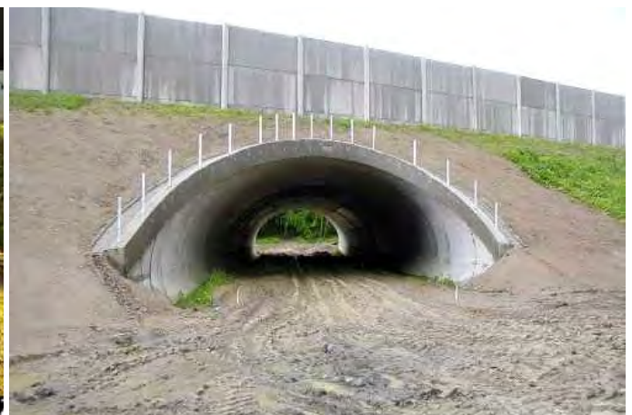
Obr. 10.22 Chování živočichů v blízkosti podchodu jasně poukazuje na to, že vnímají hluk způsobený projíždějícími vozidly (foto vlevo). U přesypávaných konstrukcí (foto vpravo) vrstva zeminy tlumí hluk působený přejezdy vozidel. Pokud se navíc použije protihluková stěna, lze dosáhnout úplné eliminace rušení. Nevýhodou tohoto řešení je však vždy snížení rozměrů podchodu. © (vlevo) Hnutí DUHA, (vpravo) AOPK ČR)
