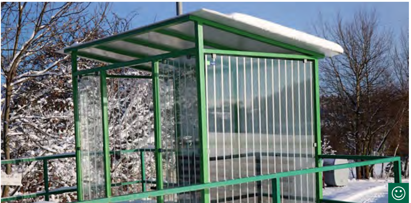
Obr. 10.57 Vysokou mortalitu ptáků můžeme zaregistrovat nejen u průhledných protihlukových stěn, ale též u autobusových zastávek. Zabezpečení proti nárazům je v obou případech obdobné. (© Václav Hlaváč)
