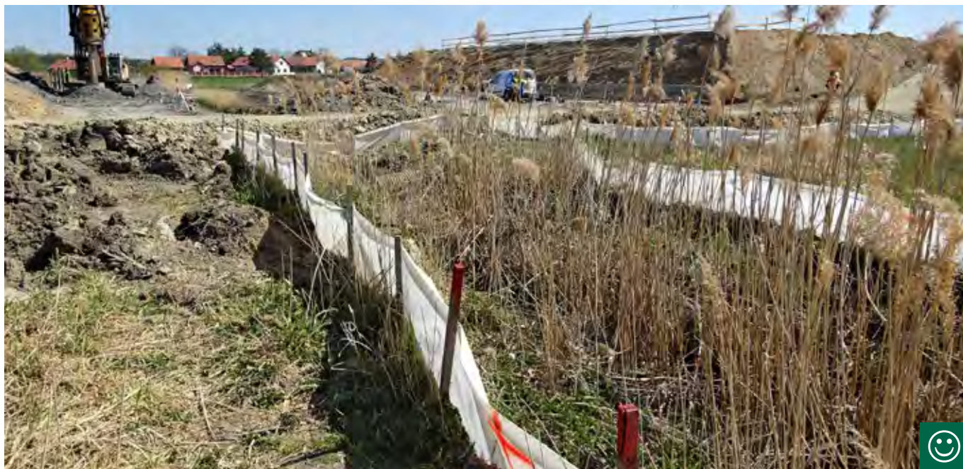
Obr. 10.69 Dočasné zábrany slouží též jako opatření, které zamezuje vstupu obojživelníků do rizikového prostoru staveniště. (© Jitka Uhlíková)
