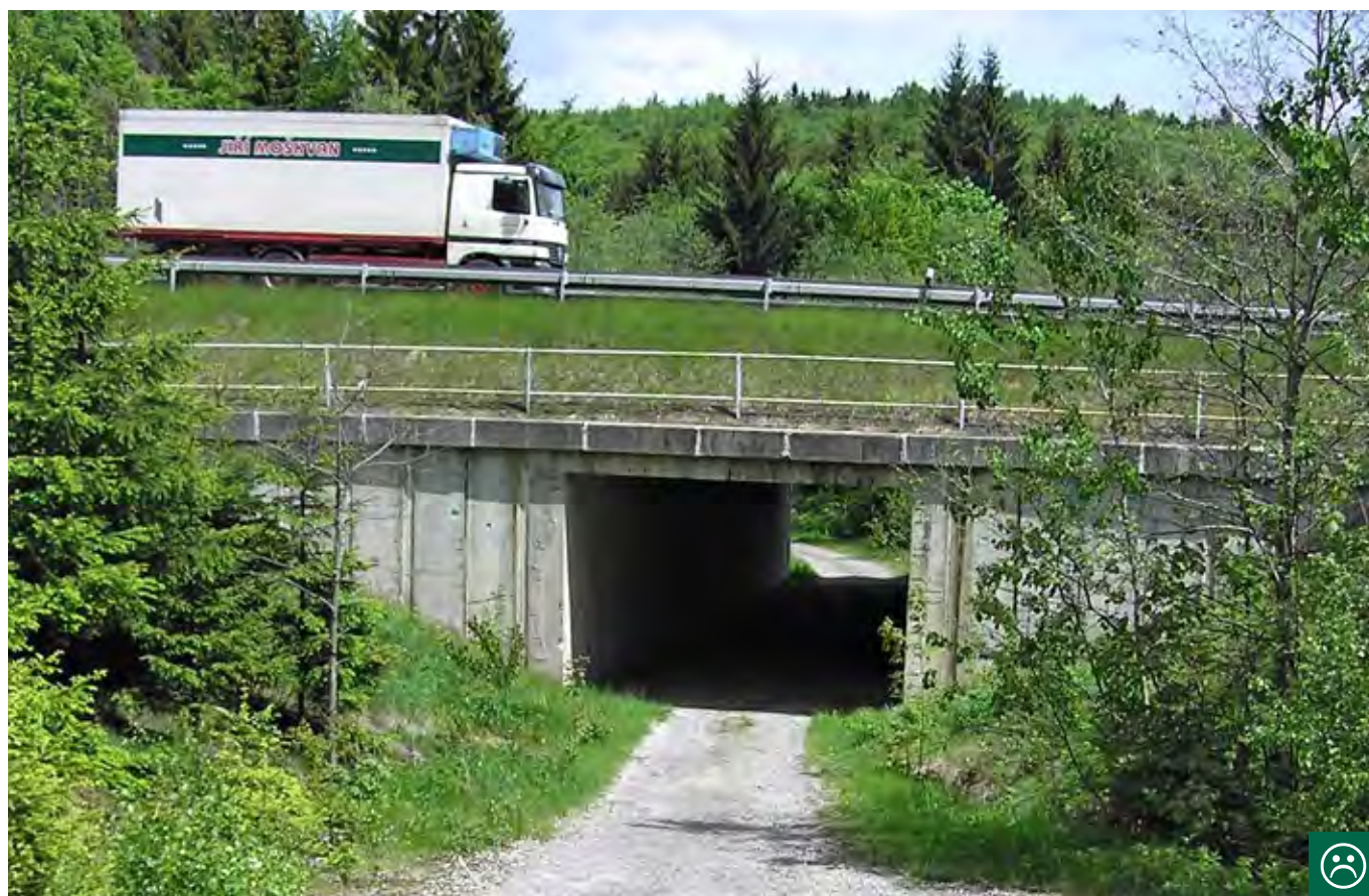
Obr. 10.37 Parametry tohoto podchodu (š = 6 m, v = 5 m, d = 33 m, tzn. I = 0,9 ) jsou nedostatečné pro velké a středně velké savce (kategorie A, B). V případě rekonstrukce by bylo vhodné takový podchod rozšířit na šířku alespoň 10 - 20 m. (© Václav Hlaváč)
