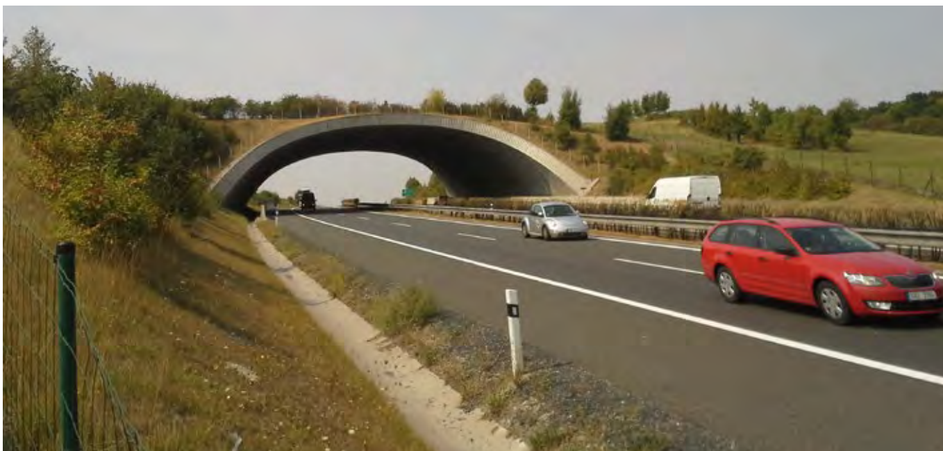
Obr. 1.3 Průchody pro živočichy jsou příkladem opatření, jejichž cílem je minimalizovat negativní dopady dopravy na volně žijící živočichy. (© Tomáš Benda)
