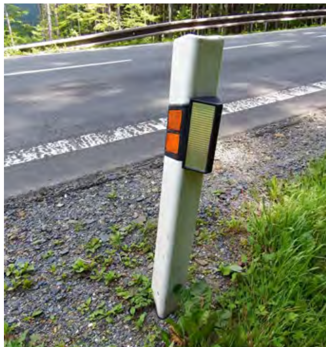
Obr. 12.21 Optický odpuzovač zvěře montovaný na silniční patník. Reflexní prvek odráží světlo od blížícího se auta ke straně silnice a tím varuje zvířata. Míra poklesu úmrtnosti živočichů v důsledku instalace těchto vizuálních odrazujících prostředků nebyla dosud uspokojivě stanovena. CHKO Beskydy. (© Danuše Bartošová)
