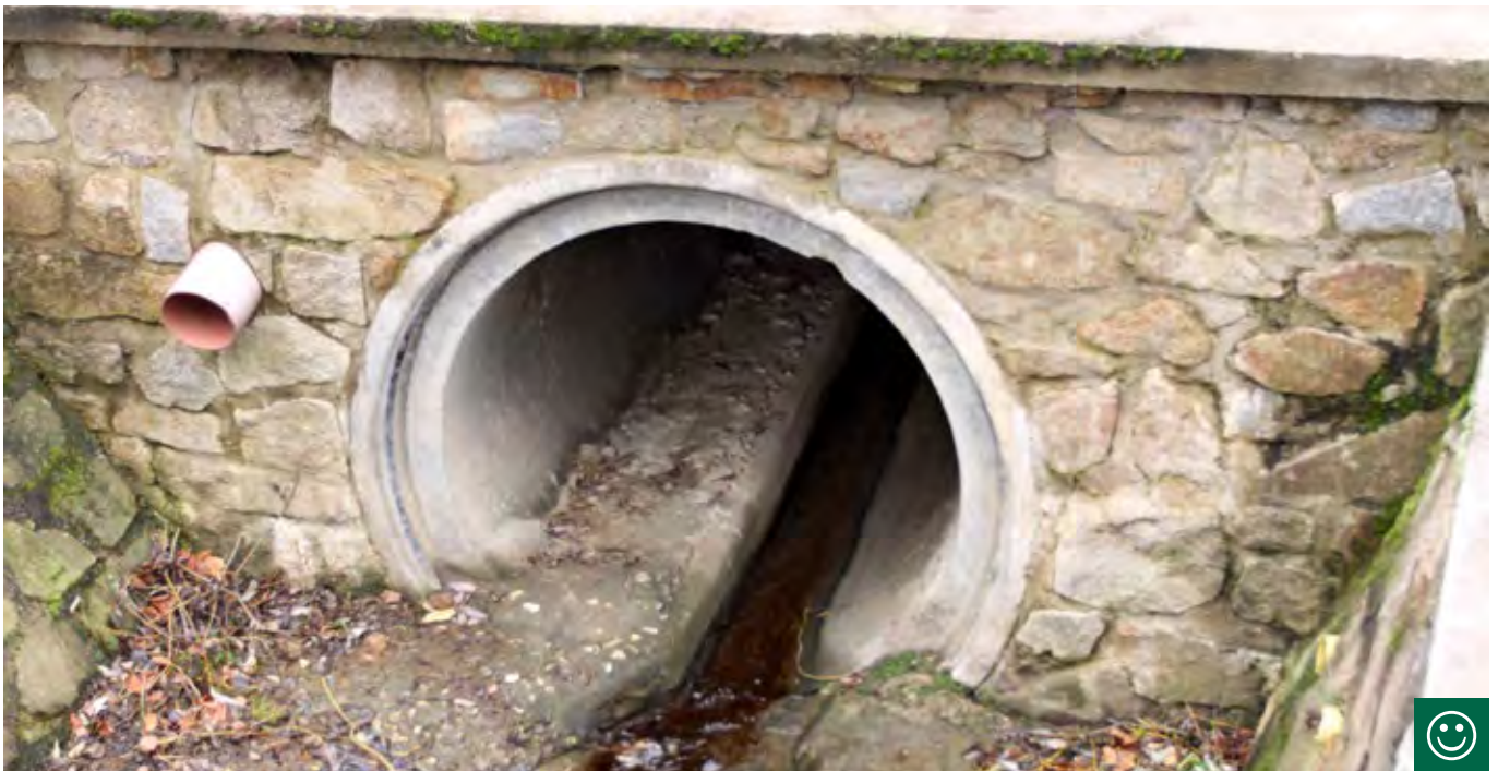
Obr. 10.26 Trubní propustky větších rozměrů se stálým průtokem mohou být upravené tak, aby umožnily průchod i suchozemským živočichům. (© Václav Hlaváč)
